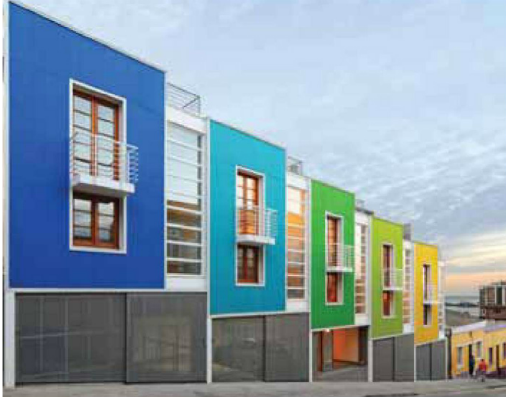
Yungay II es un edificio de 20 unidades, tipo lofts, de uno, dos y tres niveles.
